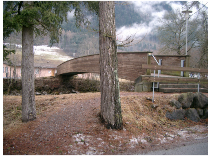
Sicht vom Parkplatz in Richtung Schützenhaus
